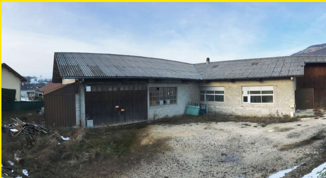
Sillingy - Ancienne serrurerie (Subvention Fonds Vert)
