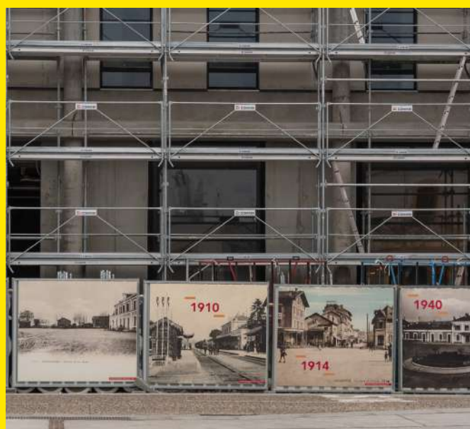
"Travaux d'aménagement sur l'écoquartier de l'Etoile"
