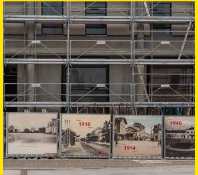
"Travaux d'aménagement sur l'écoquartier de l'Etoile"
