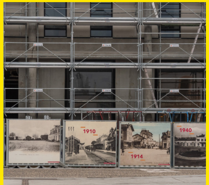
"Travaux d'aménagement sur l'écoquartier de l'Etoile"
