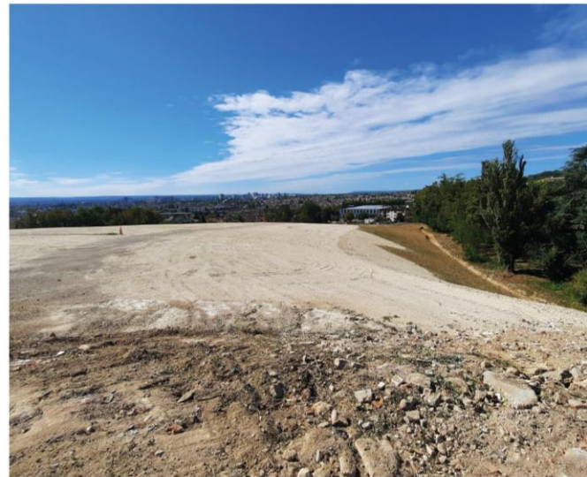
Le site en 2011 : l'essentiel du remblais réalisé
