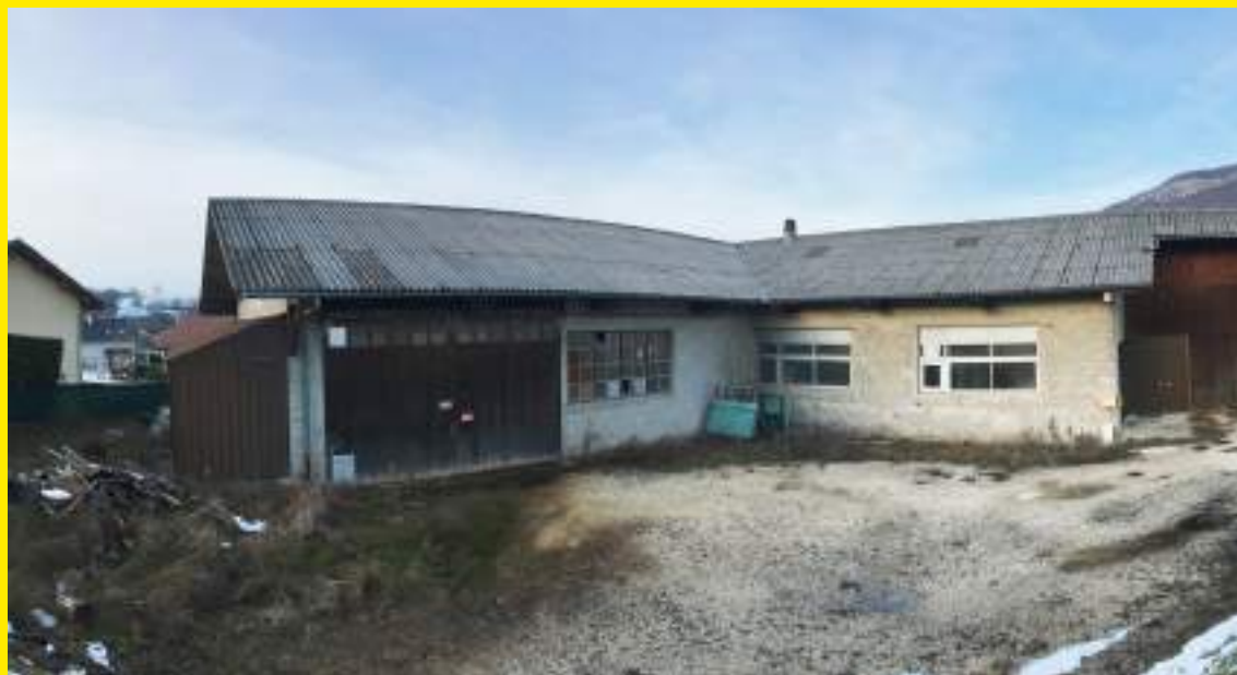
Sillingy - Ancienne serrurerie (Subvention Fonds Vert)
