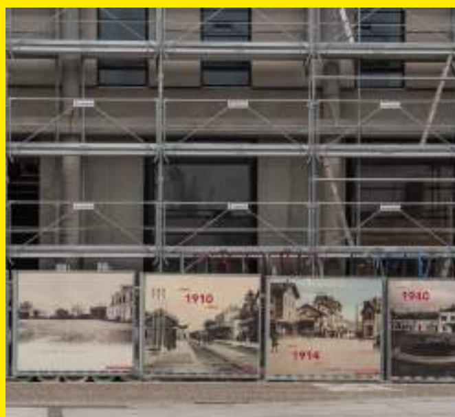
"Travaux d'aménagement sur l'écoquartier de l'Etoile"
